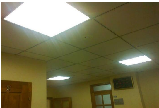
Пример освещения офисного помещения
