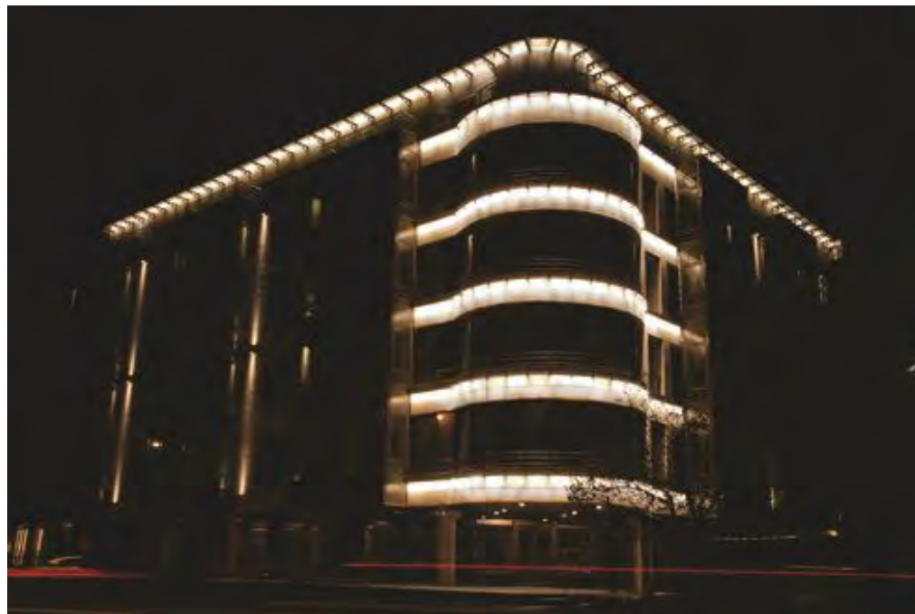
Жилой комплекс “Course House”, Москва. Светодиодные светильники серий IntiLINE, IntiROLL+ CY, позволяющая регулировать яркость подсветки.
