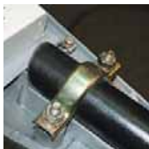
Узел крепления к кронштейну
