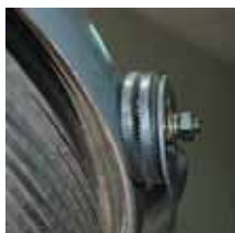
Узел регулировки угла наклона светильника
