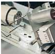
Замена блока ПРА
