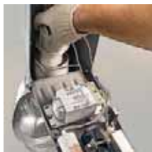
Замена лампы в светильнике с IP65
