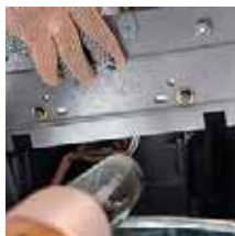
Замена блока ПРА
