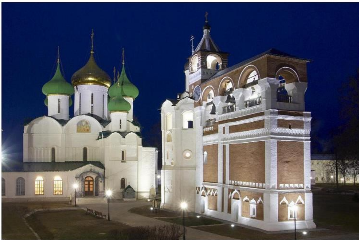
Спасо-Евфимиевский монастырь, г. Суздаль. Использованное оборудование: светильники серий IntiROLL, IntiRAY, IntiGROUND.
